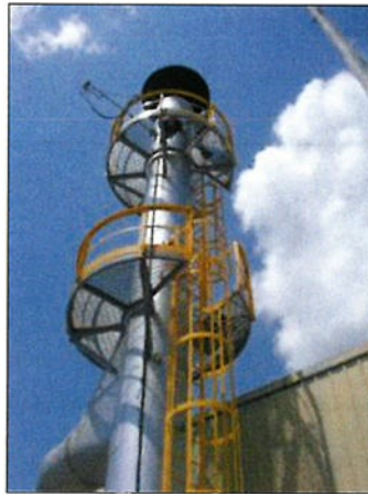
ภาพที่ 2.2-1 ปล่องหม้อไอน้ำ (Boiler)
