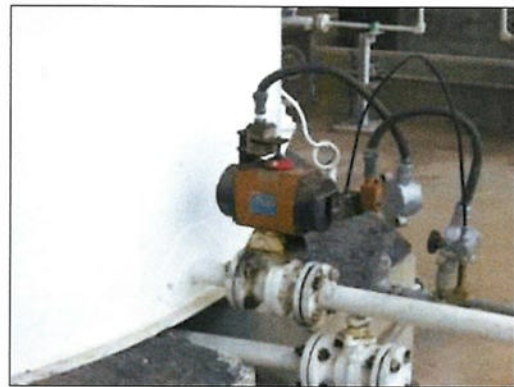
วาล์วตัดแยกระบบในกรณีฉุกเฉิน (Emergency Block Valve)
